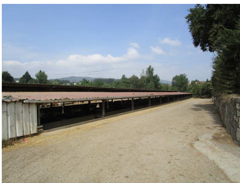
Figura 2 - Vista geral dos pavilhões existentes
