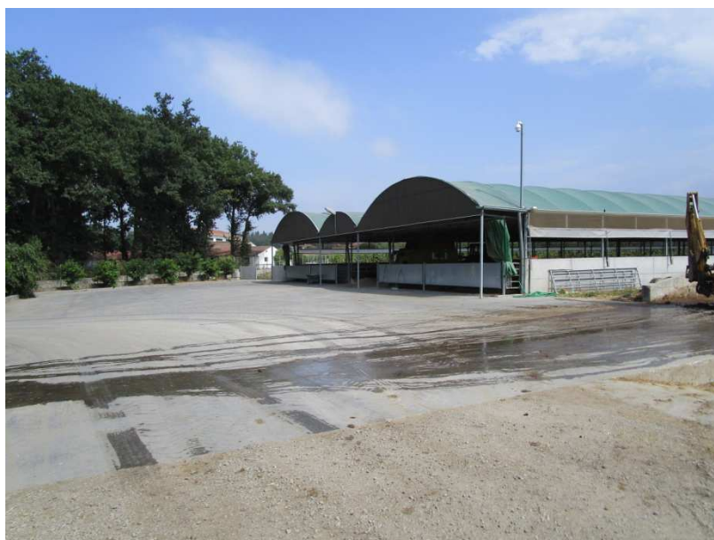
Figura 1 - Vista geral dos pavilhões existentes
